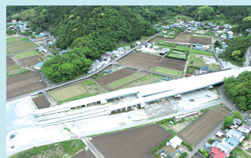
静浦バイパス 大平側施工状況(空撮)
